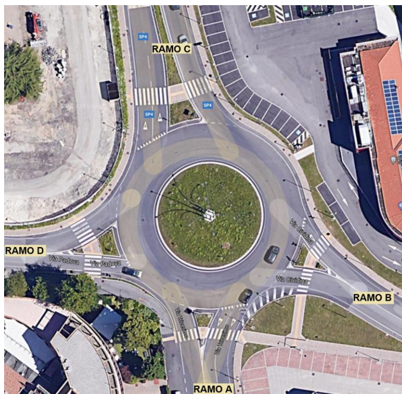
Fig. 3 – Rotonda esistente tra viale Tricesimo e le vie, Cividina, Nazionale e Padova con le codifiche utilizzate nelle verifiche di capacità (estratto da Google Maps)
