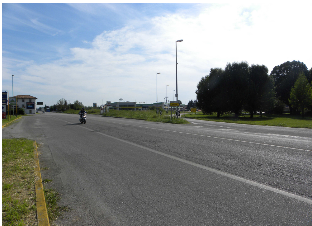
intersezione Adegliacco, vista verso sud
