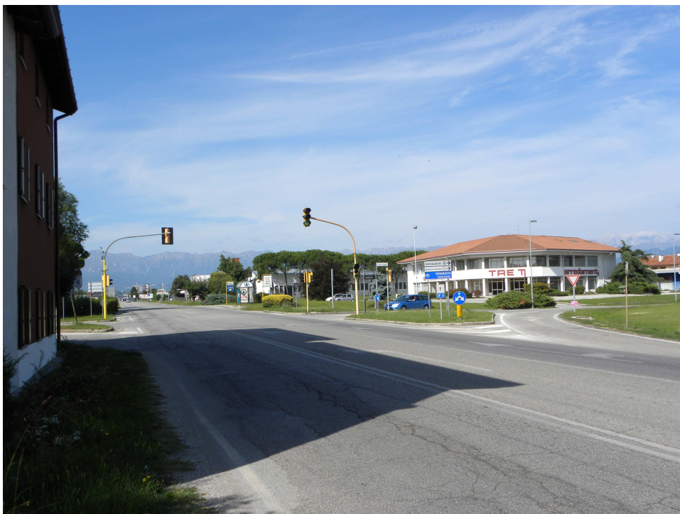
intersezione semaforica a Cavalicco, vista verso nord
