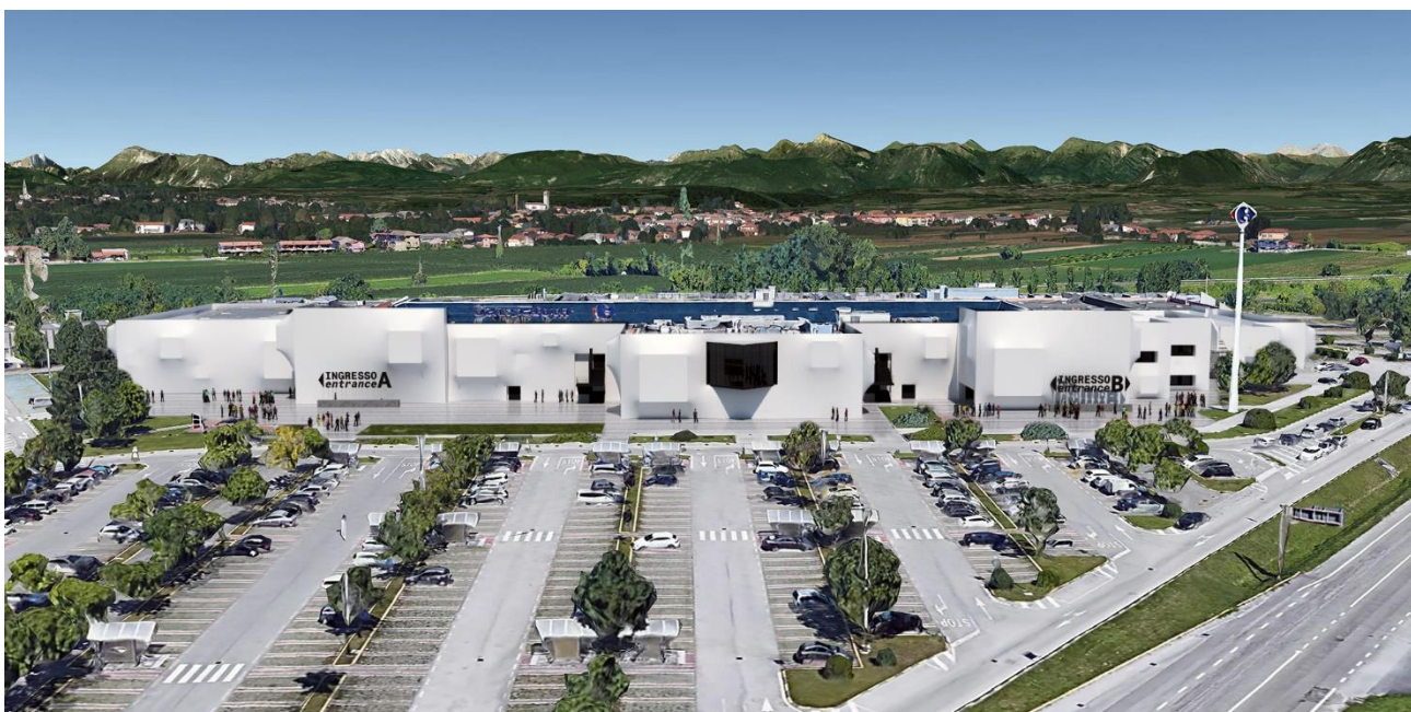
Figura 2 - Vista del CCT Friuli da SP4 Tresemane
