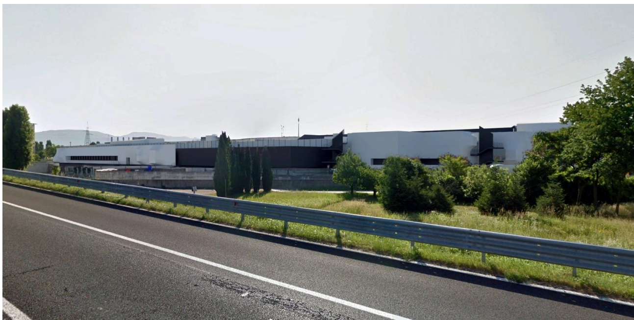
Figura 3 – Vista del CCT Friuli dalla SS13
